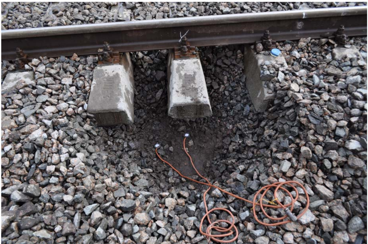
Рисунок 4.21 – Приклад встановлення месдоз на дослідній ділянці
