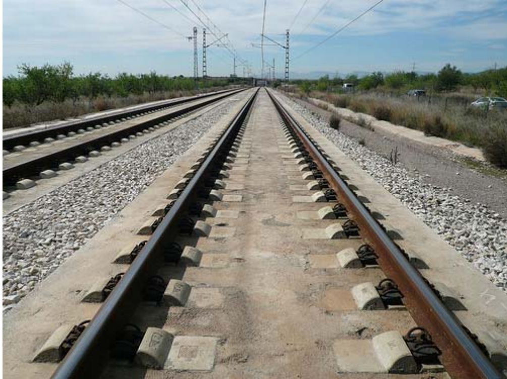
Рисунок 5.18 – Реальний вигляд безбаластної конструкції колії Rheda [198]
