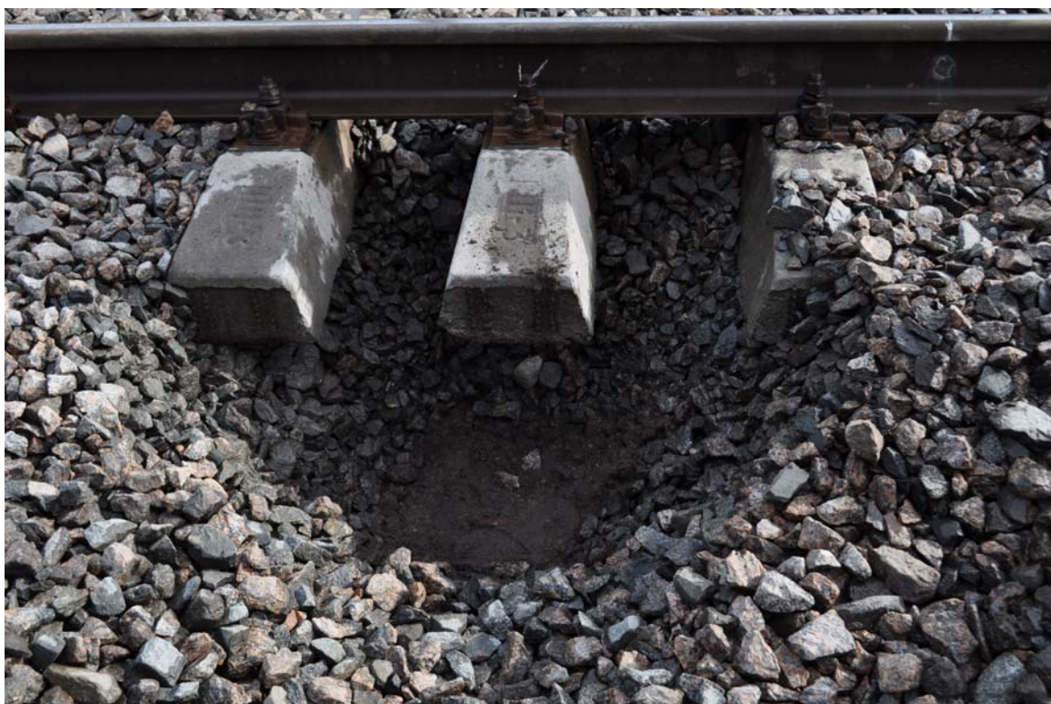
Рис. Д.1 – Підготовка місця для встановлення месдоз
