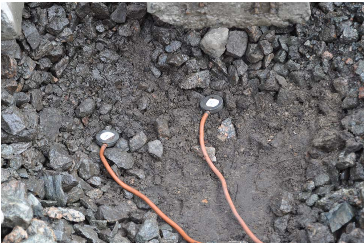
Рис. Д.5 – Встановлення 2-го рівня месдоз
