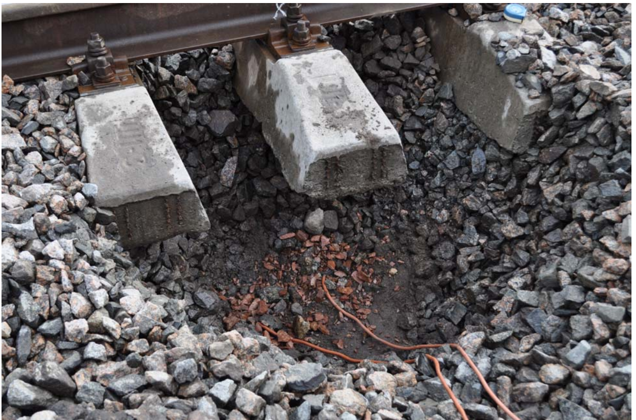
Рис. Д.3 – Встановлення 1-го рівня месдоз
